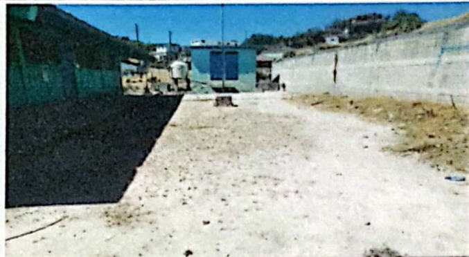
Sustitución de piso de torta de concreto
