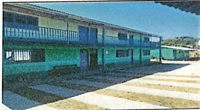
Sustitución de piso de torta de concreto
