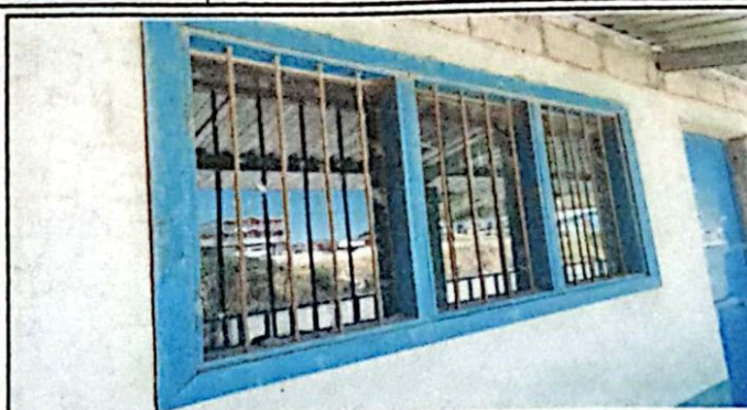
Sustitución de ventanas de madera por metal mas vidrio
